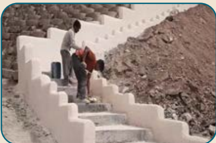
بهسازی پله ارتباطی منطقه شهرک گلستان
