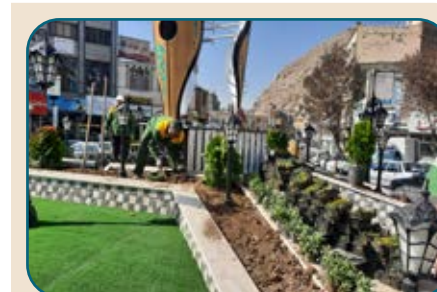
اجرای گلکاری میدان‌ها و سطح شهر
