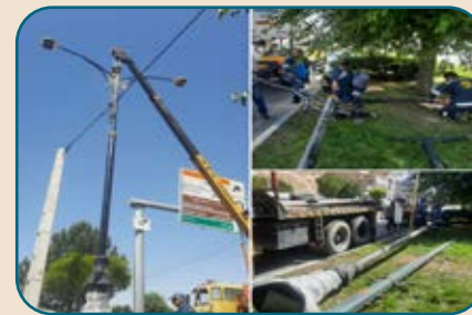
تعویض تیر برق های بلوار ۴۵ متری فیروزکوه
