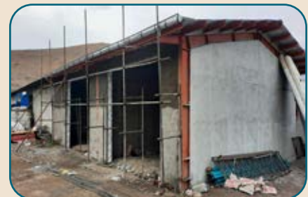
احداث سوله انبار نمک در خدمات شهری
