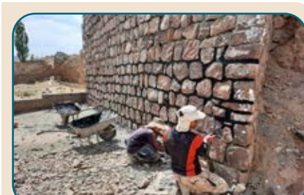
احداث دیوار حائل در سطح شهر
