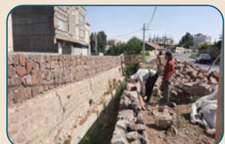
افزایش ارتفاع دیوار حائل نهر کنگرخانه
