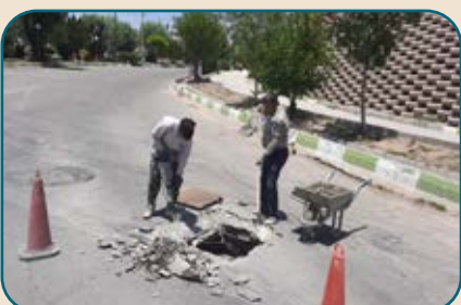
اصلاح و بهسازی معابر سطح شهر
