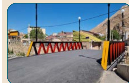
مرمت و ترمیم پل تختی
