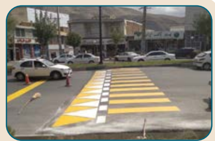
احداث و رنگ آمیزی سرعت کاه در سطح شهر
