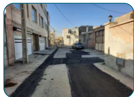
لکه‌گیری آسفالت نوار حفاری ۴۵ متری
