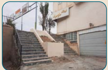
بهسازی پله ارتباطی منطقه هندورزان
