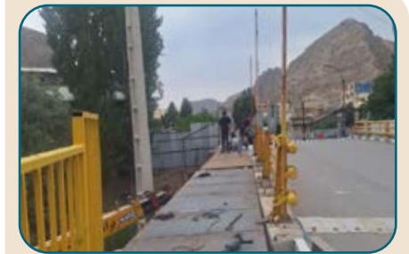
احداث پل عابر جنب پل ۱۸ متری
