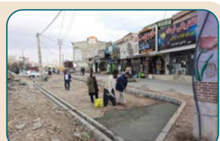
اجرای پروژه اصلاح هندسی میدان امام خمینی (ره)
